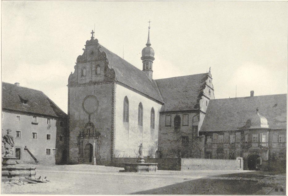
Klostergebäude in Tüchelhausen
