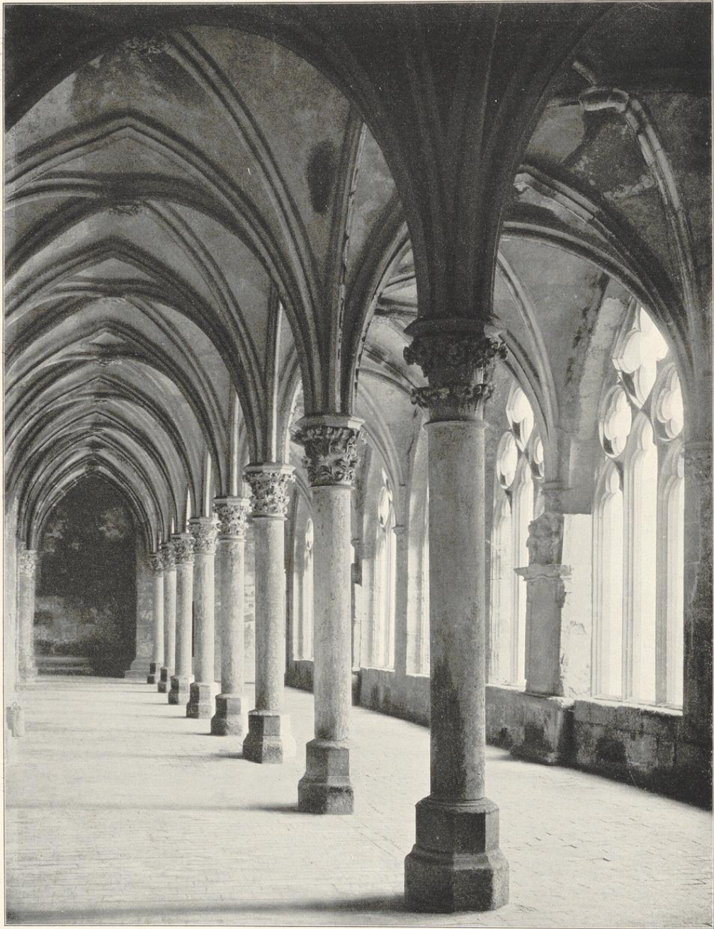
Walkenried. Kreuzgang der ehemaligen Cistercienserkirche. Anfang des 13. Jahrh.
