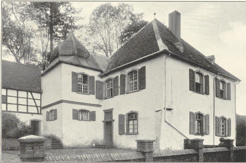
Nordostansicht des Hauptgebäudes.
