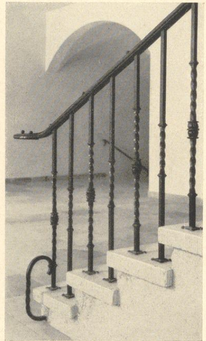
Oben: Teilansicht des Flures mit kleinem Brunnenbecken. Rechts: Einzelheit aus dem nördlichen Treppenhaus; hinten rechts der Zugang zum Turnhallenflügel.
