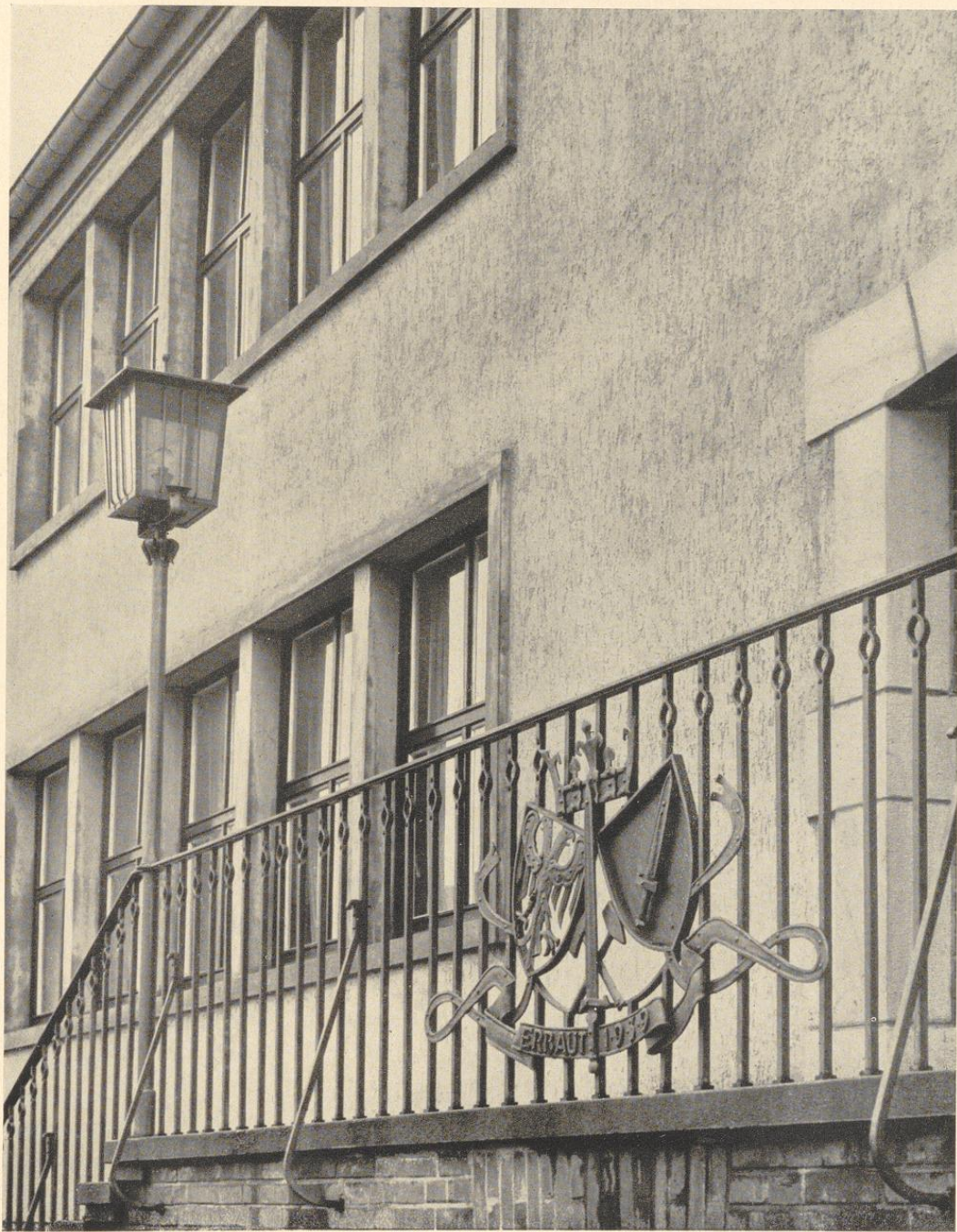
Einzelheiten des Brüstungsgitters am Haupteingange des Klassengebäudes mit dem Wappen der Stadt Essen. Entwurf: K. H. Scherer; Ausführung: W. Elberskirch, Essen.
