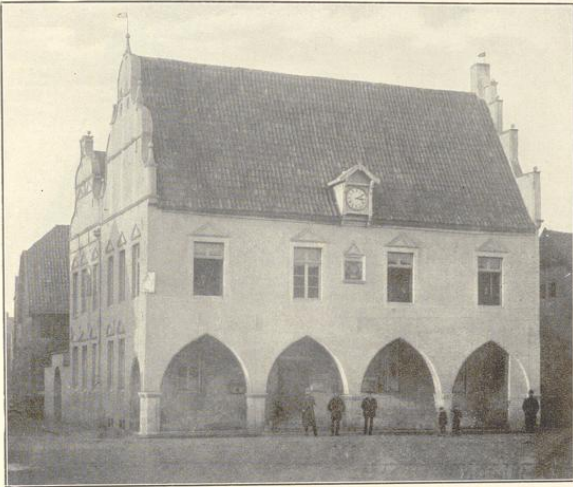
Rathhaus vor der Erneuerung.
