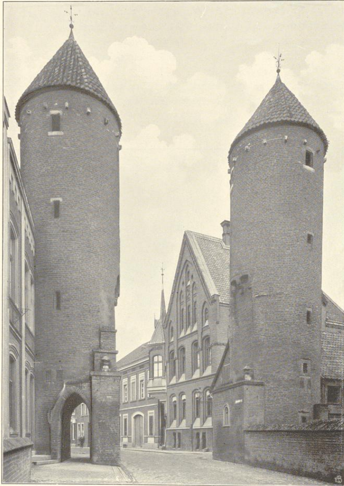
Lidinghauser Chor (vor der Erneuerung).
