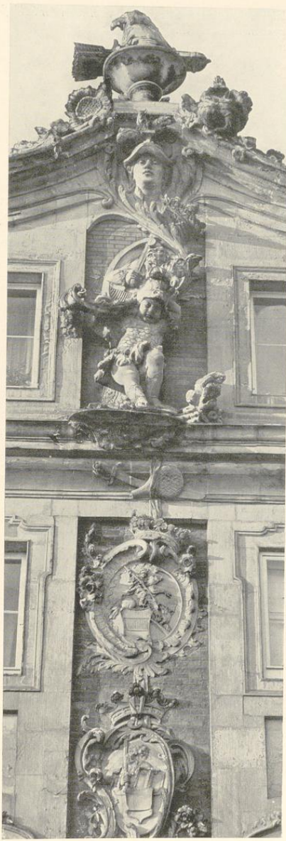
Abb. 202. Die Mitte der Ostseite des Nordpavillons
