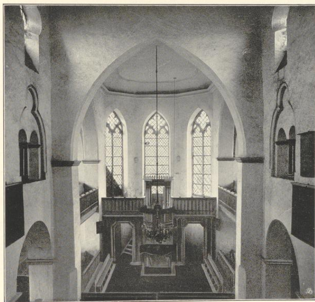
Innenansicht nach Osten vor der Wiederherstellung.
