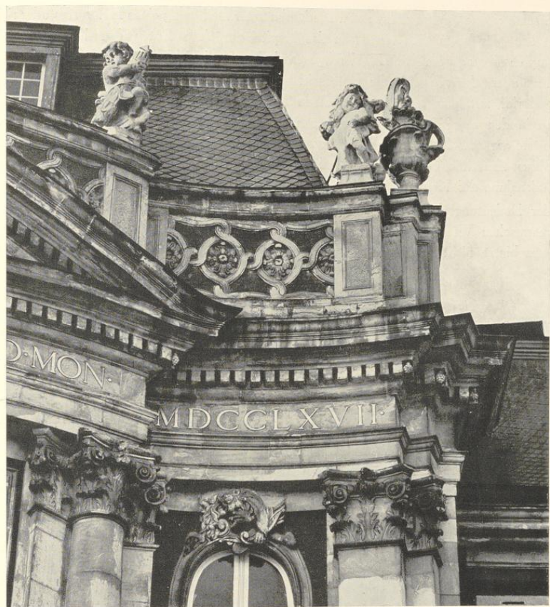
Abb. 199. Das Gebälk des Hauptpavillons, Ostseite, nördliche Hälfte
