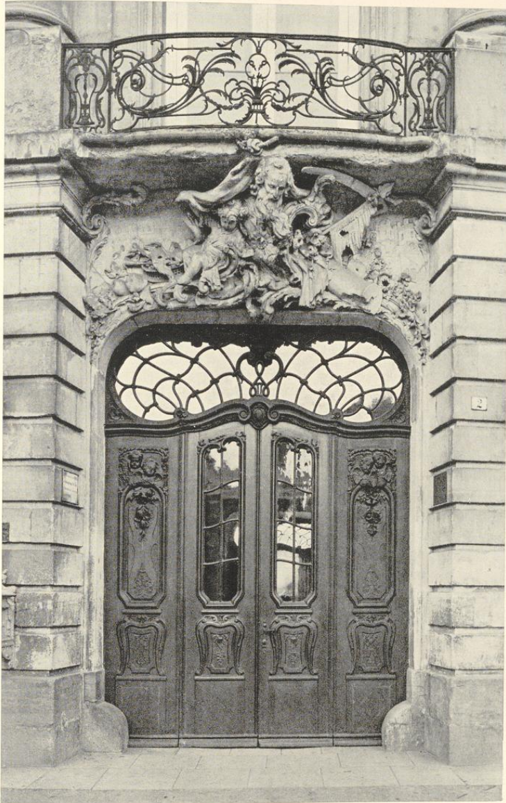
Abb. 195. Das Mittelportal der Ostfront (Tür und Oberlicht von 1898)
