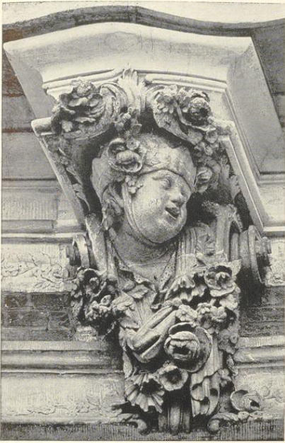
Abb. 203. Der Frühling. Schlussstein über dem Süd- fenster des Erdgeschosses des Mittelpavillons
