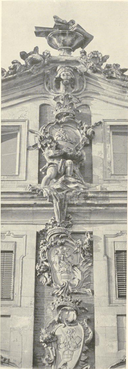
Abb. 201. Die Mitte der Ostseite des Südpavillons
