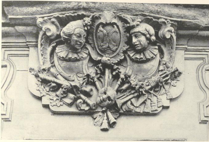
Abb. 206. Februar, Skulptur über dem nördlichen Fenster im Risalit auf der Ostseite des Südpavillons
