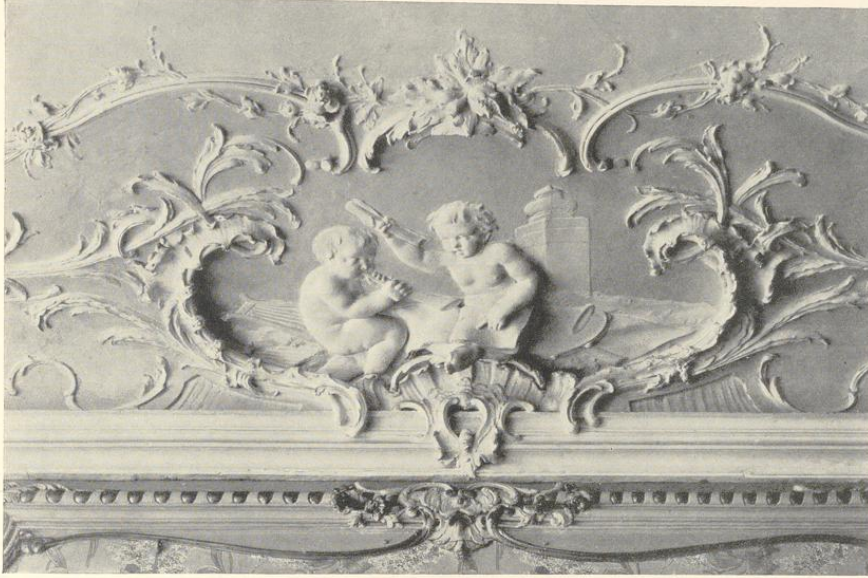
Abb. 232. Stuckdecke des ersten Kabinetts, Mittelteil an der Westwand
