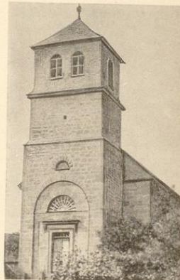
2. Kirche. Turm. Ansicht
