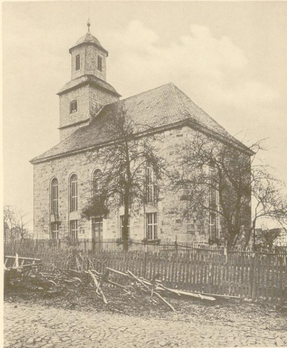
2. Ansicht von Südosten
