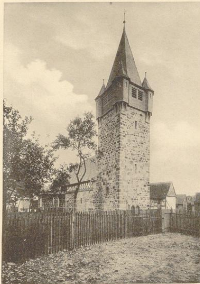
3. Außenansicht. Jetziger Zustand
