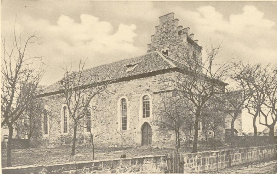
1. Ansicht von Südosten
