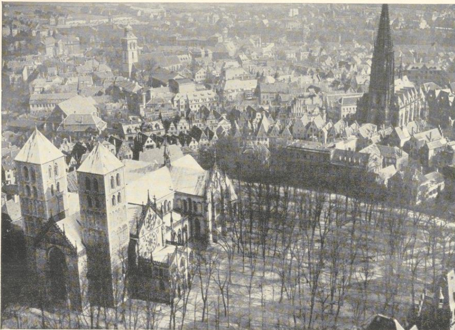
Abb. 317. Fliegeraufnahme des Domhofes von Südwesten Aufnahme des Städtischen Verkehrsamtes
