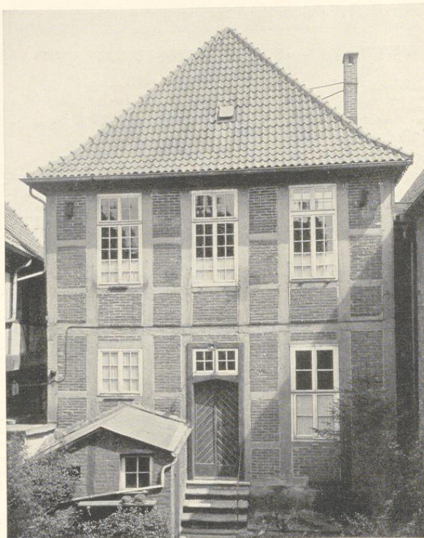
Abb. 453. Die Westseite des Hauses Horstberg 13 Aufnahme 1933
