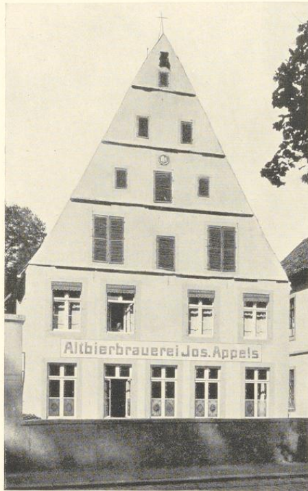
Abb. 670. Das Haus Neubrückenstraße 12/14 vor dem Umbau 1926
