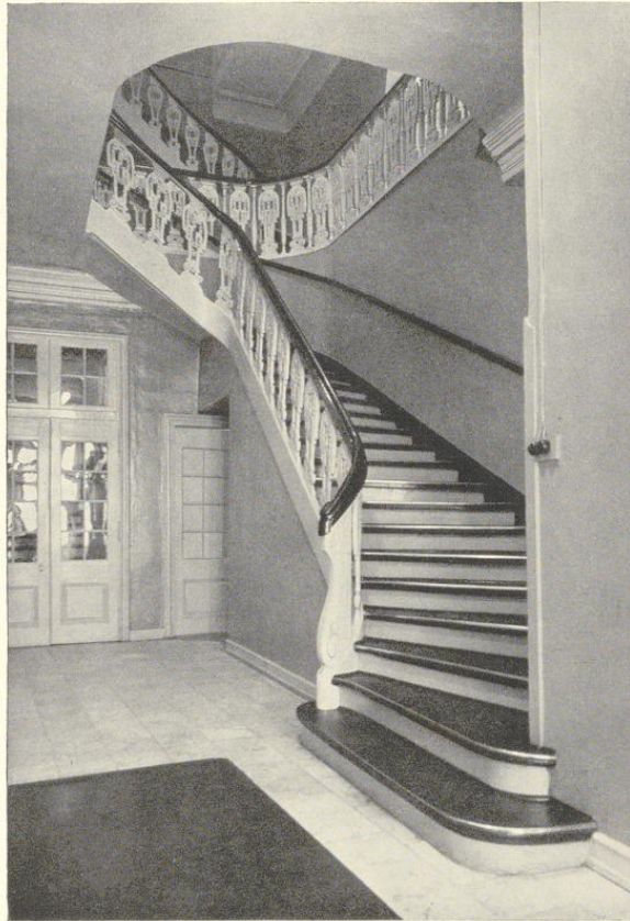
Abb. 854. Das Treppenhaus des Hofes Neubrückenstraße 4
