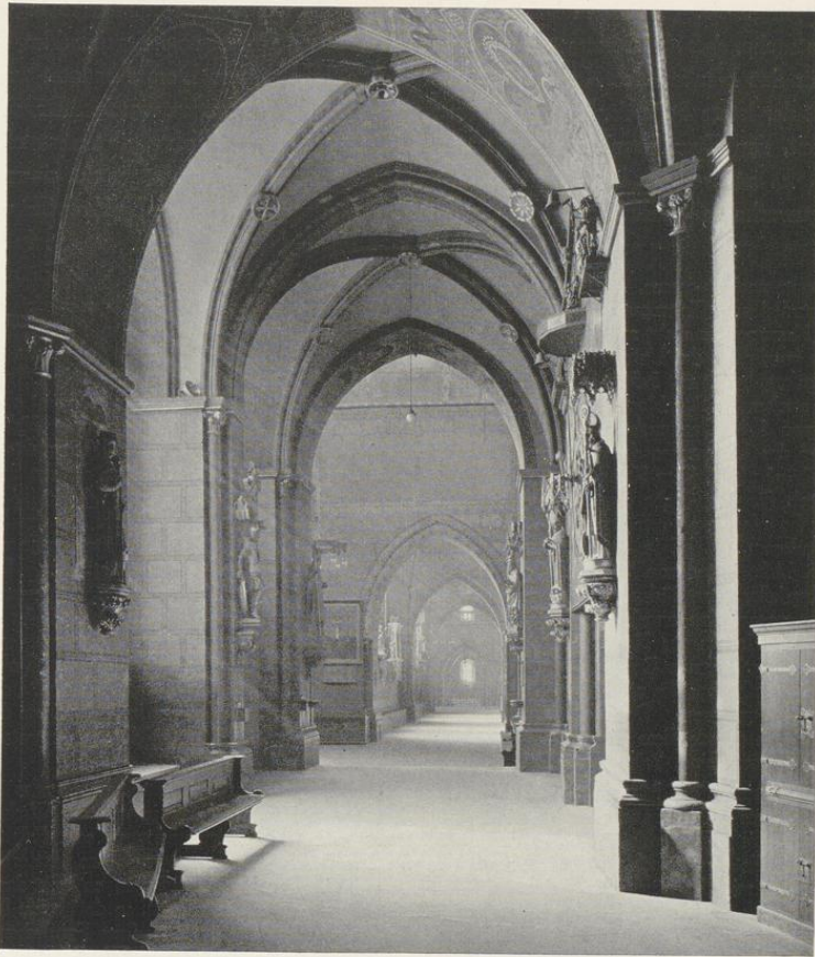
Abb. 1383. Blick in das südliche Seitenschiff von Osten Aufnahme 1931
