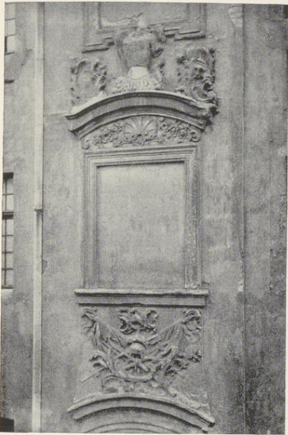
Abb. 1138. Umräumung vom Nordrisalit
