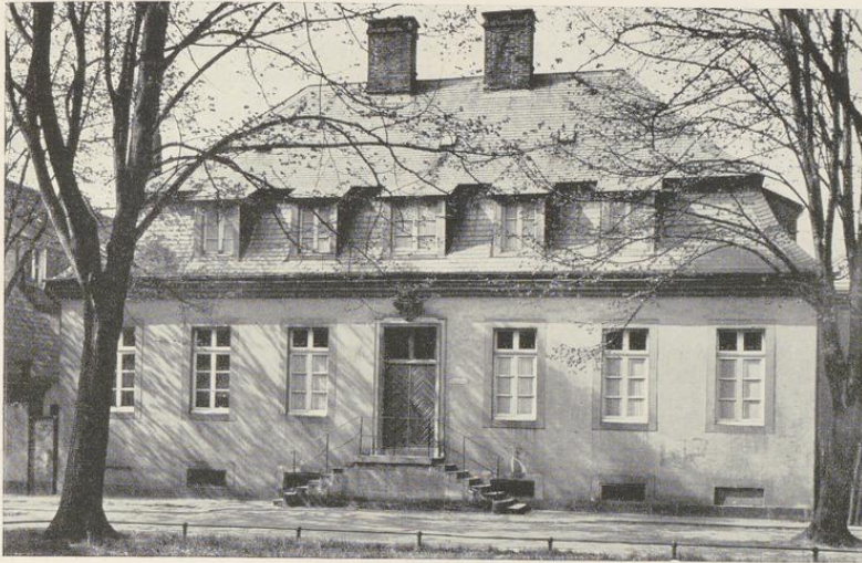
Abb. 1121. Das Pfarrhaus von St. Maurit, Mauritzsteinfeld 16, von Süden
