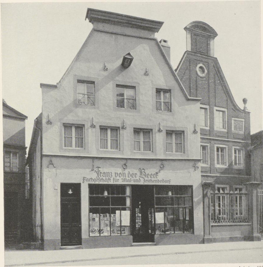
Abb. 1365. Die Fronten der Häuser Agidiistraße 7 (links) und 8 (vgl. S. 176)
