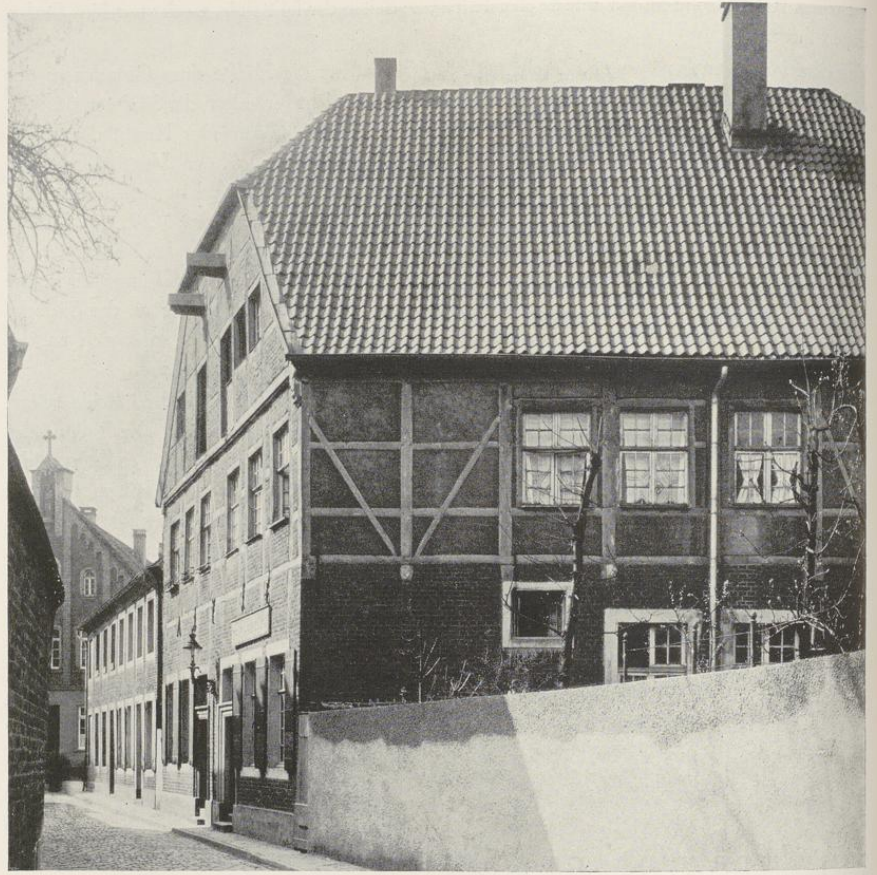
Abb. 989. Das Doppelhaus Krumme Straße 43/44 von Nordosten
