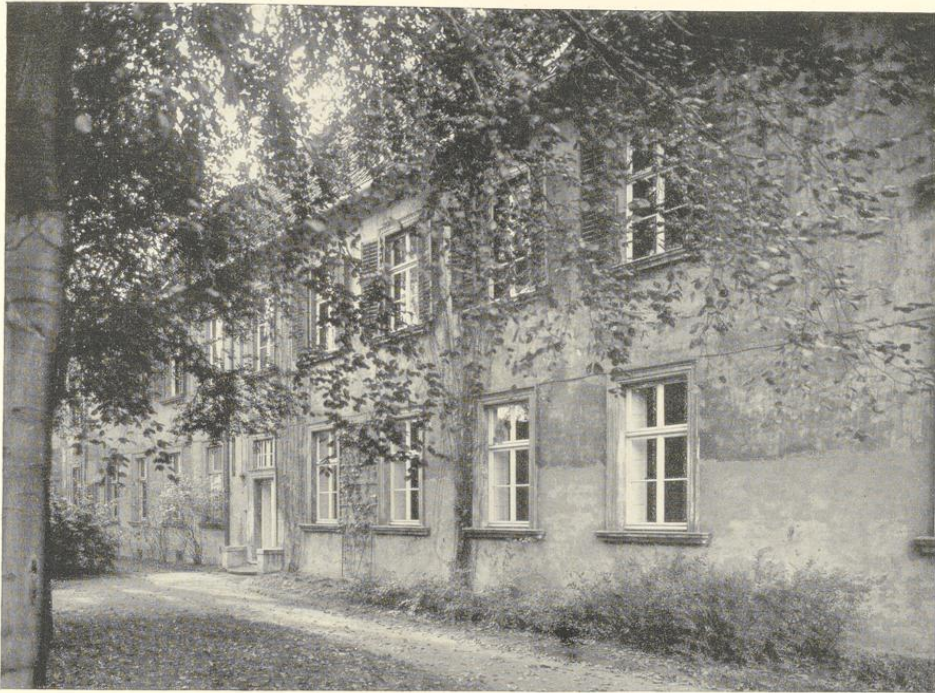
Abb. 901. Die Ostfront des Hofes Hindenburgplatz 10/12. Aufnahme von Nordosten
