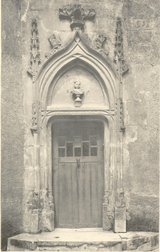
CIVRAY (Vienne). HOTEL DE LA PRÉVOTÉ. Porte et fenêtre sur la rue Louis XIII. Fin du XV e siècle.
