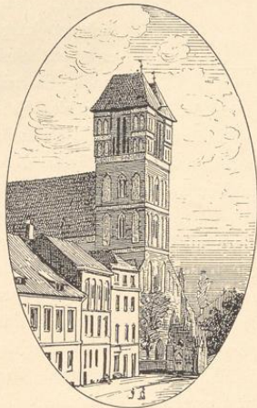
Fig. 28. St. Jacobskirche am neuen Markt.
