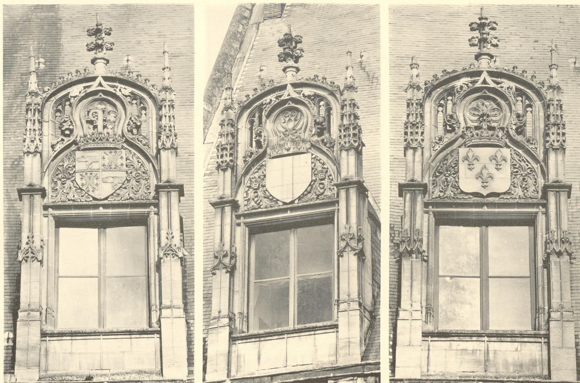
BEAUVAIS. ANCIEN PALAIS EPISCOPAL (AUJOURD'HUI PALAIS DE JUSTICE). Lucarnes de la face principale. Commencement du XVI e siècle.
