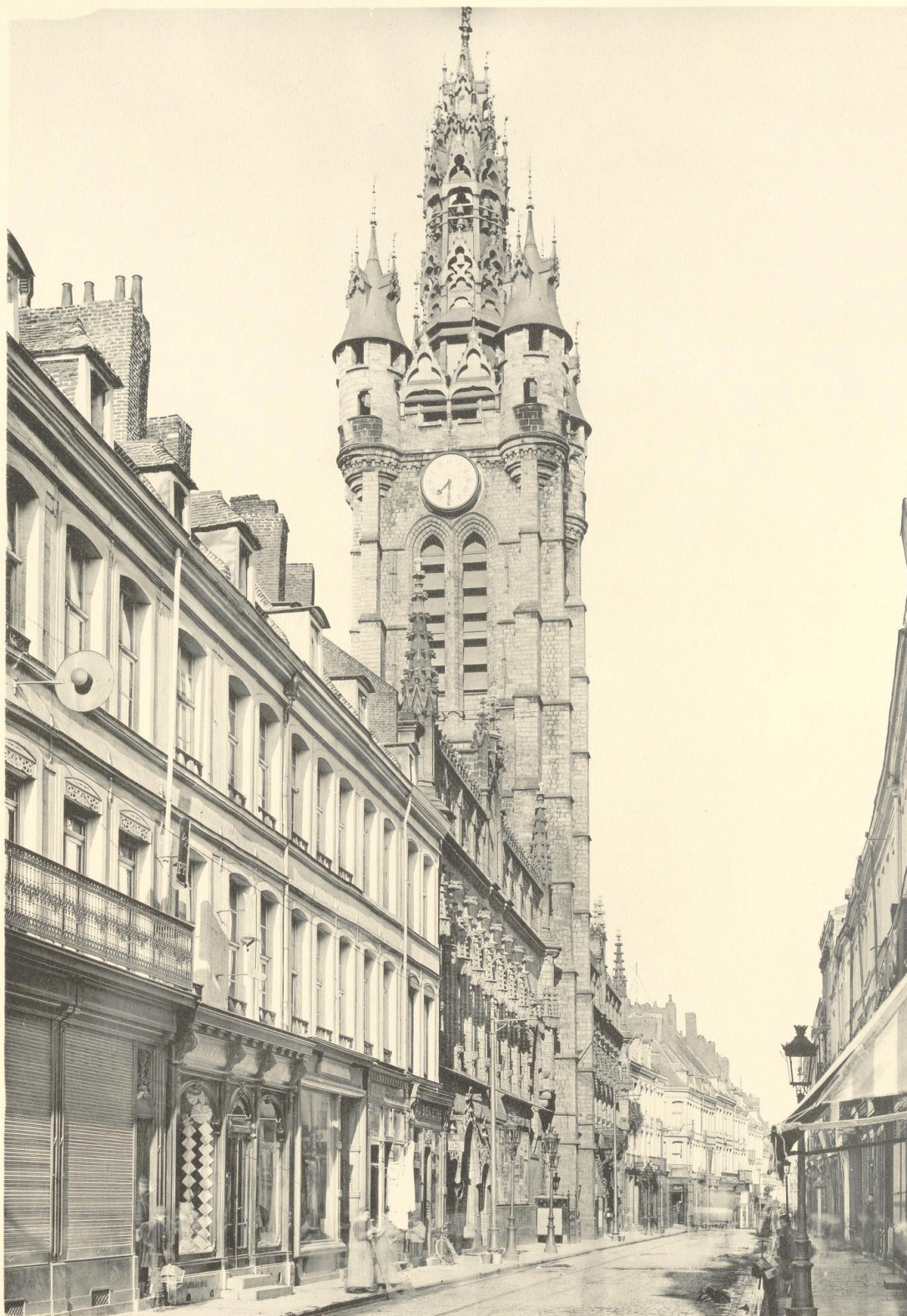
DOUAI. HOTEL DE VILLE. Belfroi et façade principale. Fin du XV e siècle.
