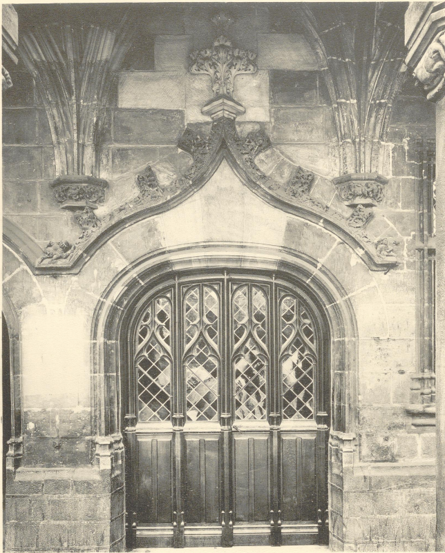
SAINTE-QUENTIN. HOTEL DE VILLE. Porte d'entrée et arcade du rez-de-chaussée. Commencement du XVI e siècle.
