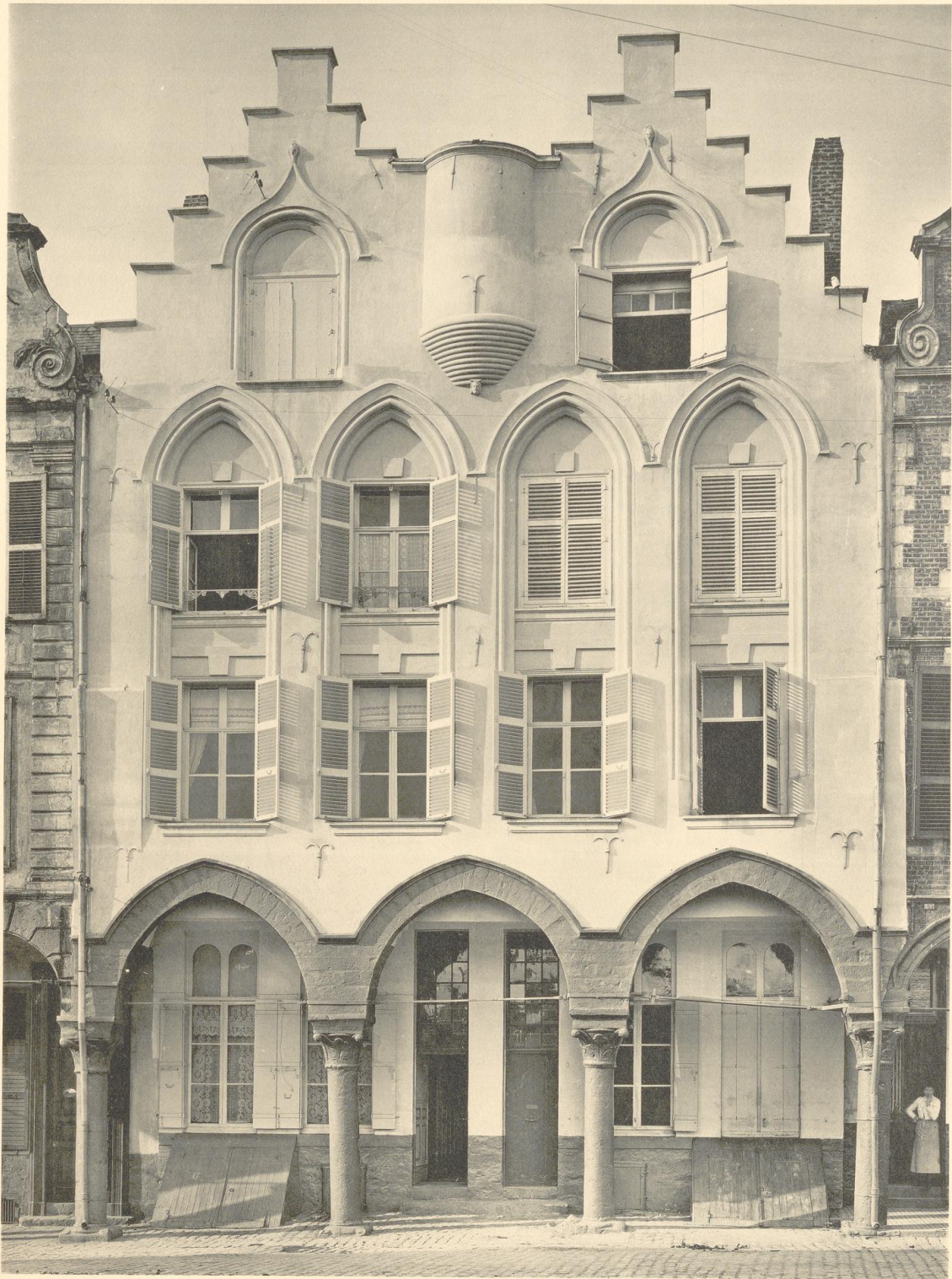
ARRAS. MAISON DE LA GRAND'PLACE, n° 49.
