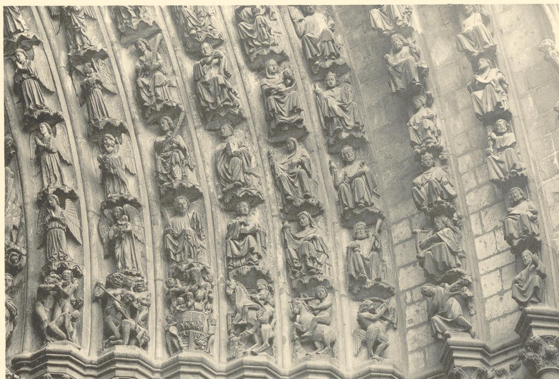
CATHEDRALE D'AMIENS. Tympan et voûtures de la porte centrale.
