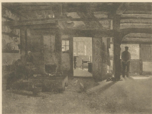
Abb. 1. Diele aus dem Held'schen Hause, früher in Ostenfeld, jetzt überführt nach Husum; erb. 1673. (Nach einem Bilde von R. Hagn.)
