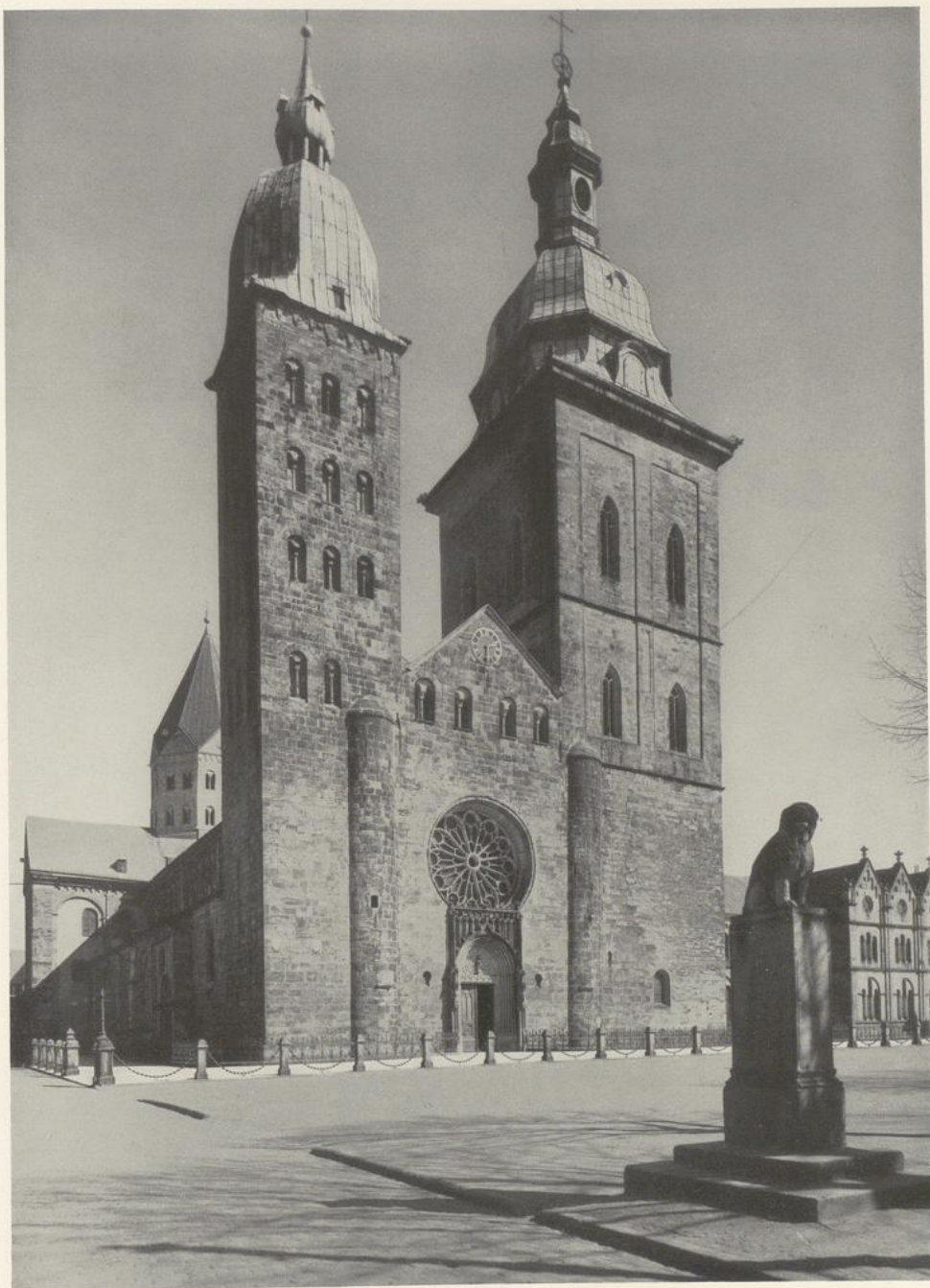
43. OSNABRÜCK. DOM VON NORDWESTEN
