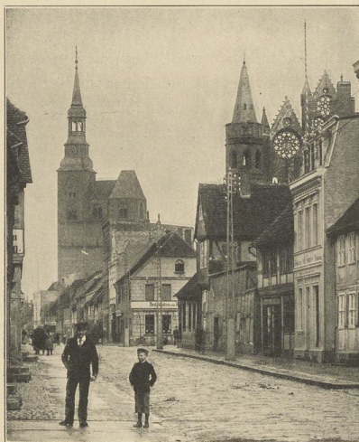
Abb. 2. Tangermünde. Blick in die Kirchstraße, ostwärts.
