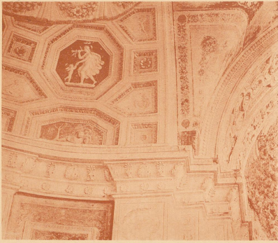
Südwestliche Ecke der Westhalle.
