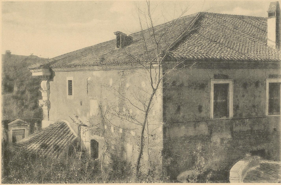
Die Villa von Südwesten.
