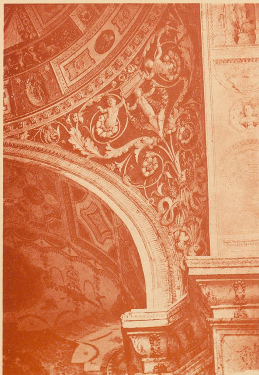
Nordwestlicher Kuppelzwickel der Mittelhalle.
