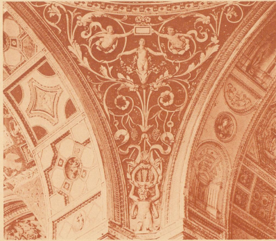
Südöstlicher Kuppelzwickel der Mittelhalle.
