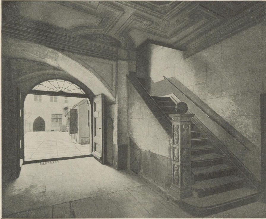
Abb. 80. Goldene Krone. Treppenhaus. (v. D.)
