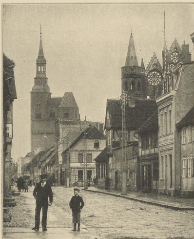
Abb. 2. Tangermünde. Blick in die Kirchstraße, ostwärts.
