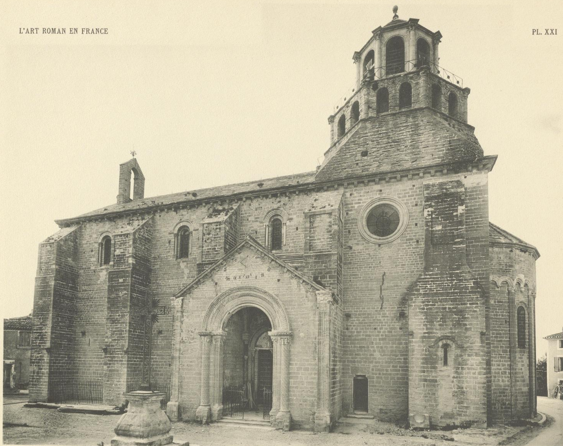
LE THOR (Vaucluse), ÉGLISE SAINTE-MARIE-AU-LAC, Vue d'ensemble et face latérale sud. Fin du XII e siècle.
