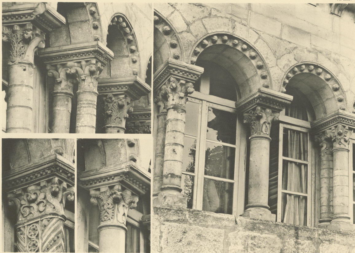
AUXERRE, ANCIEN EVÊCHÉ, détails d'arcatures. Reconstruction de 1115 à 1136.
