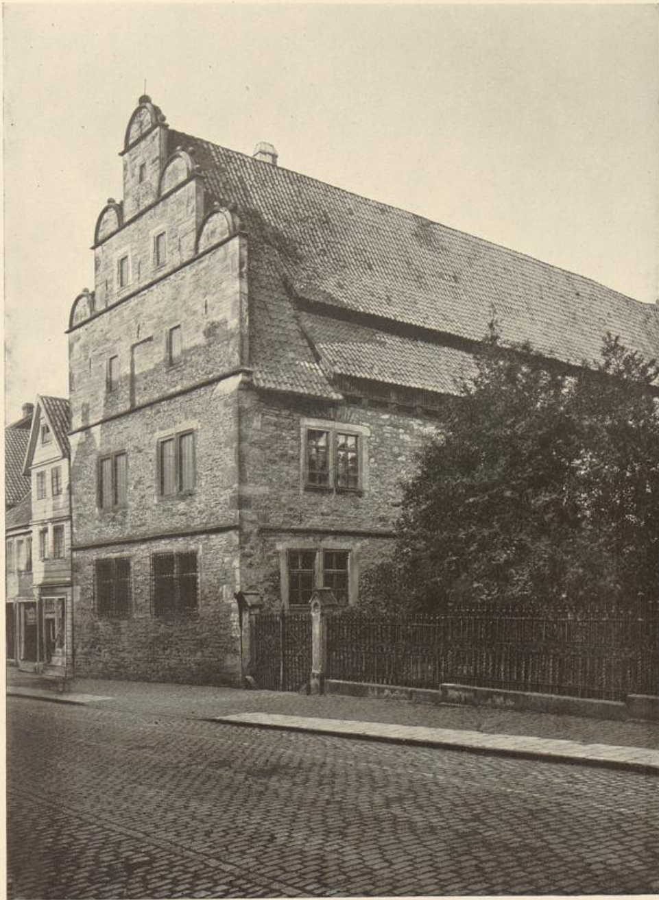
61. Schloß Stadthagen. Stallgebäude an der Straße.
