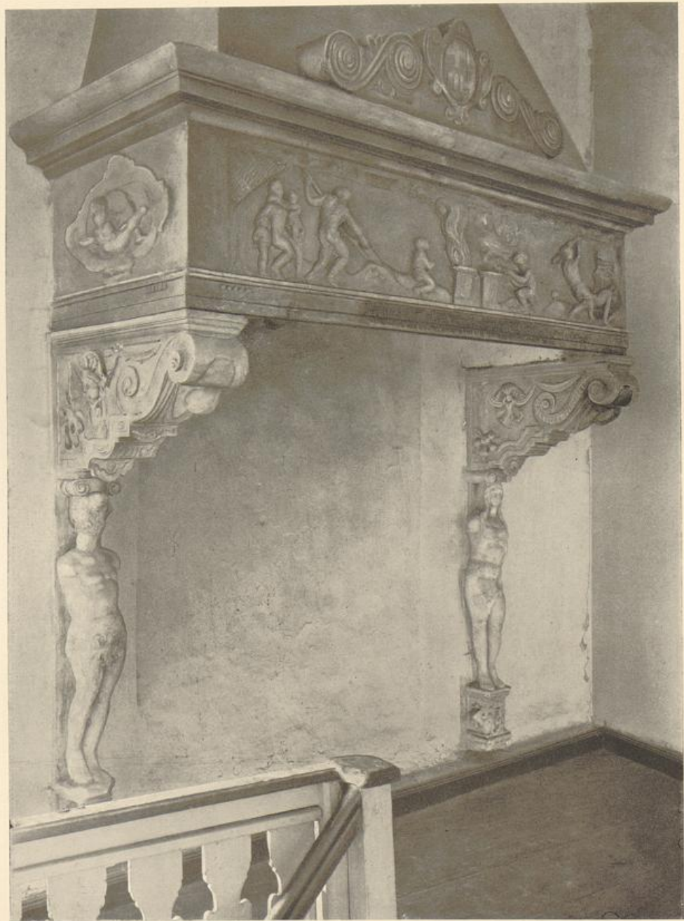
136. Wewelsburg. Kamin im jetzigen Treppenhaus.
