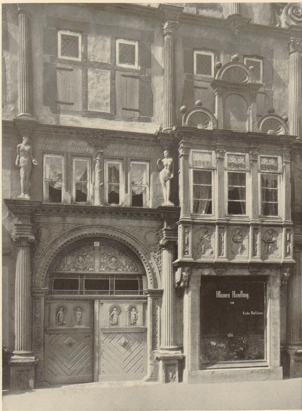
90. Lemgo. Hexenbürgermeisterhaus; Portal.
