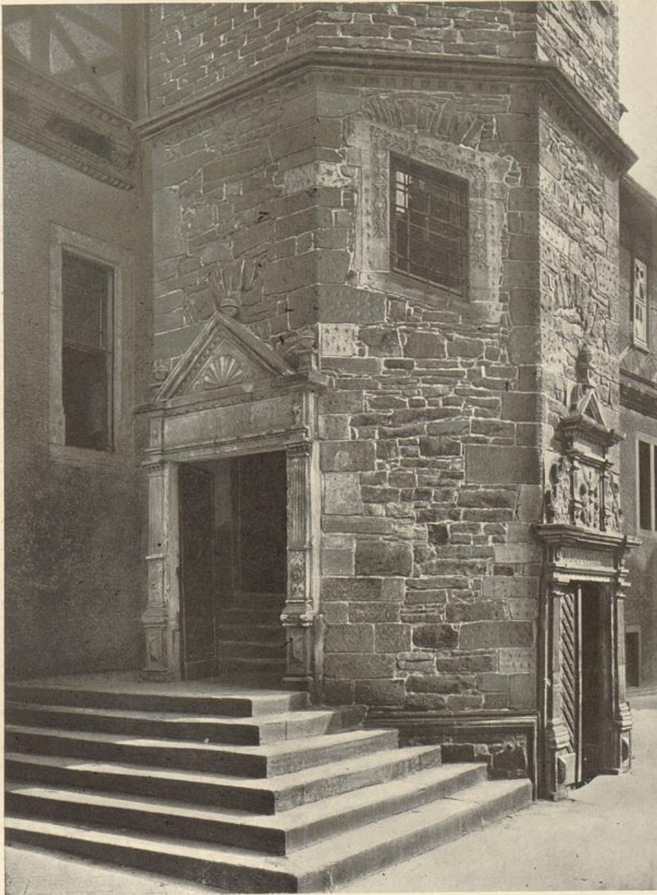
15. Rathaus in Höxter. Treppenturm.
