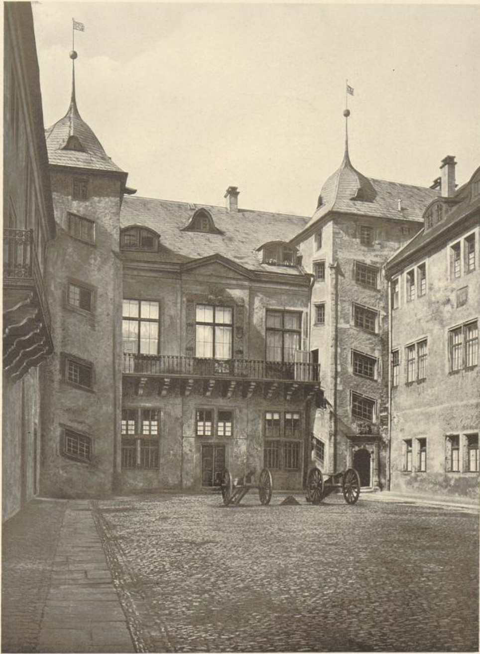
168. Schloß Detmold. Blick auf die Hofseite des Nordwestflügels.
