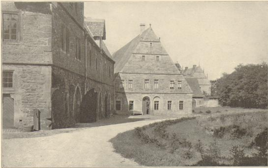
69. Schloß Stadthagen. Untergebäude.
