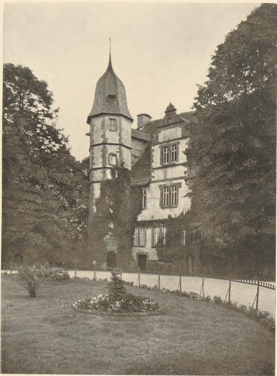
193. Schloß Wendlinghausen. Turm an der Hauptfront.
