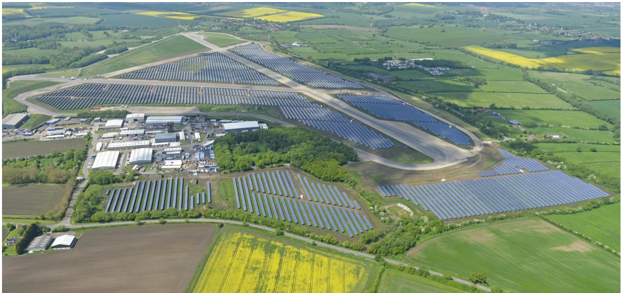
Abbildung 2.3: Foto eines 33 MW-Solargenerator (Bildquelle: S.A.G. Solarstrom AG)
