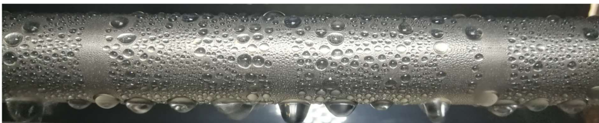
Abbildung 26: Polysilazan-Beschichtung nach 0 Betriebsstunden.
