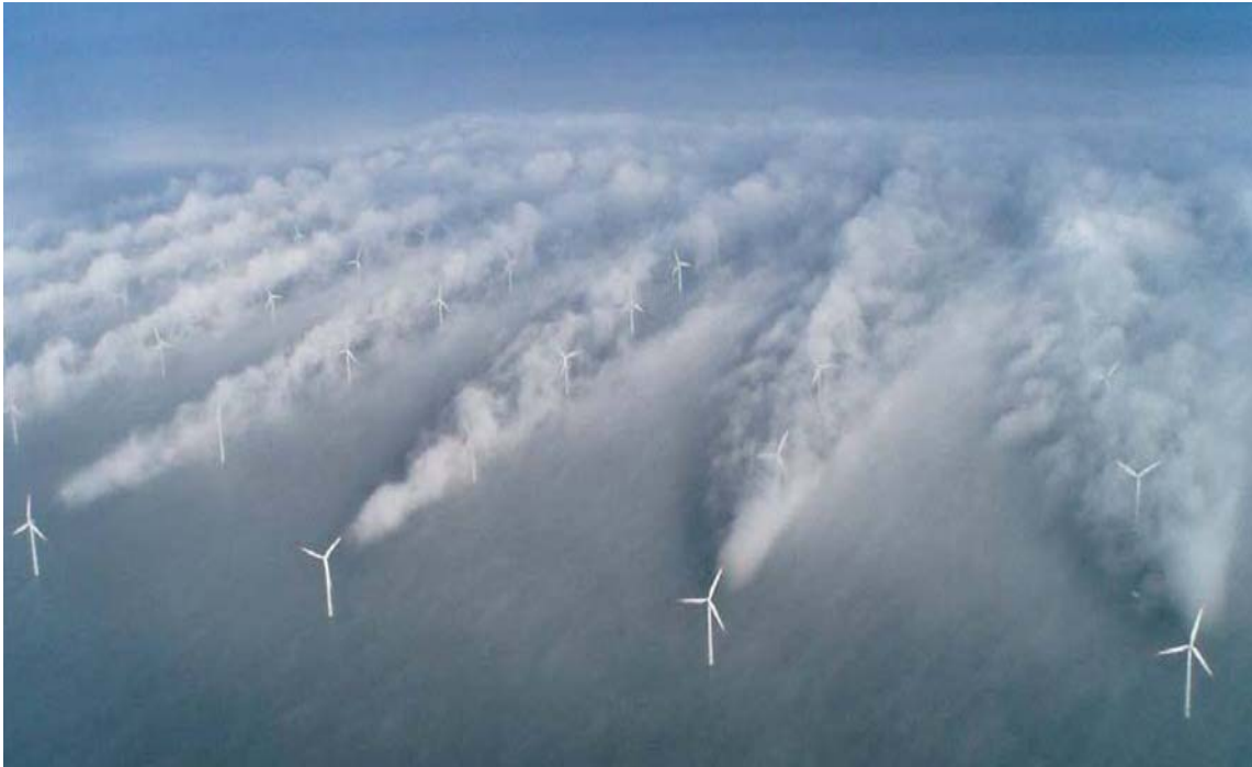
Abbildung 5.5: Darstellung der Strömungsverhältnisse im Windpark. [EWE-09]
