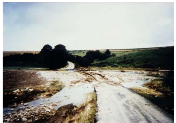
Abb. 4: Typischer „Off Site“-Schaden mit überflutetem und verschüttetem Verkehrsweg am Haarstrang. Foto: (05.09.1987)
