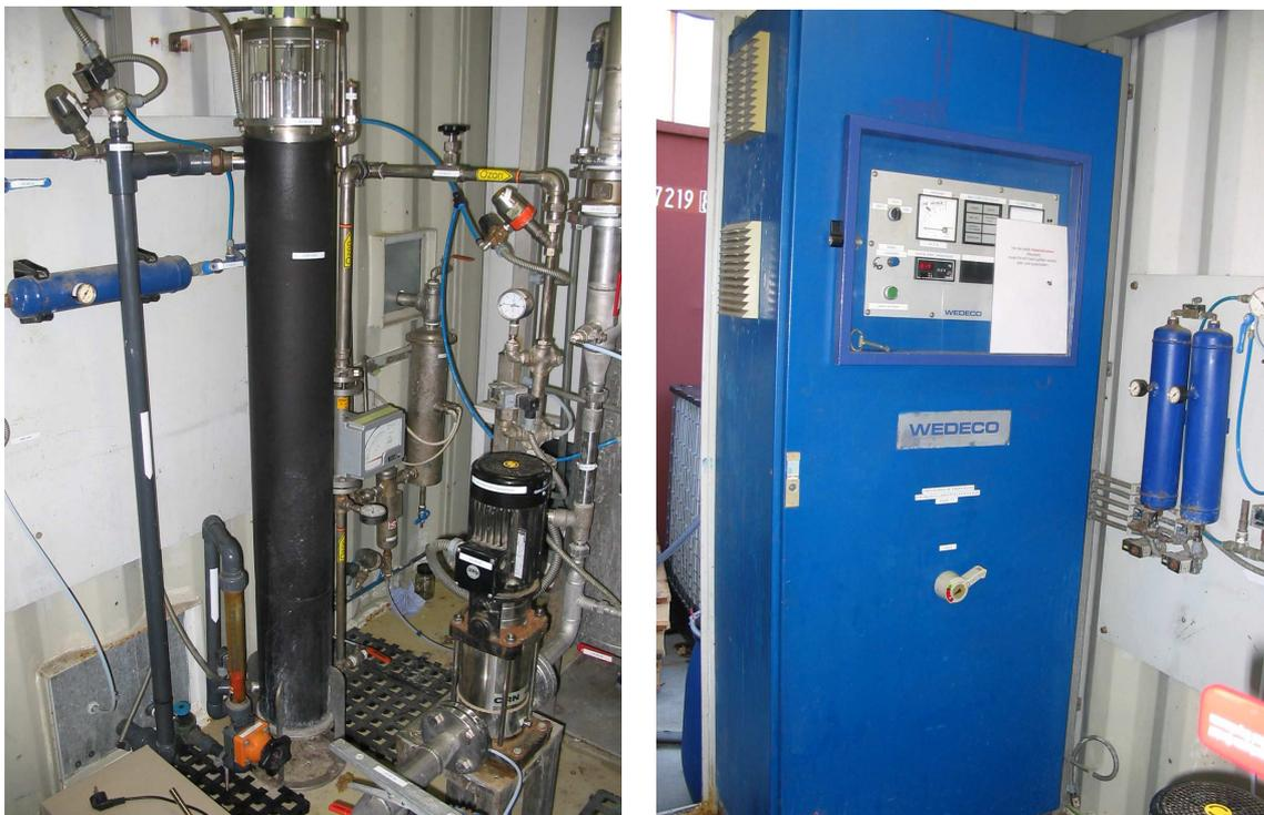
Abbildung 9.9: Ozonerzeugungsanlage Typ LWO 300 (links: Ozongenerator; rechts: Elektroschaltschrank)
