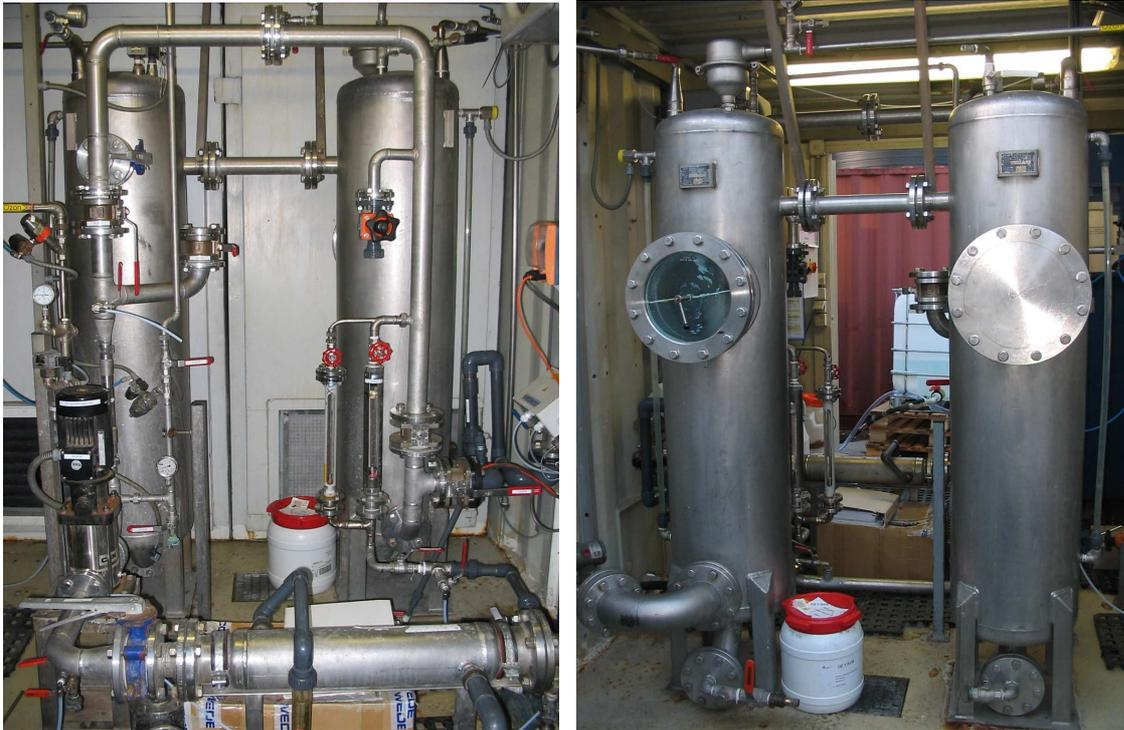
Abbildung 9.10: Ozoneintragsystem (links: Injektor, Druckerhöhungpumpe und Absorptionsbehälter; rechts: Absorptionsbehälter)
