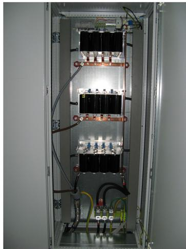
**Abbildung A.3:** Wechselrichter mit drei Semikronmodulen (weiß) und aufgeschraubten Zwischenkreiskondensator-Modulen
