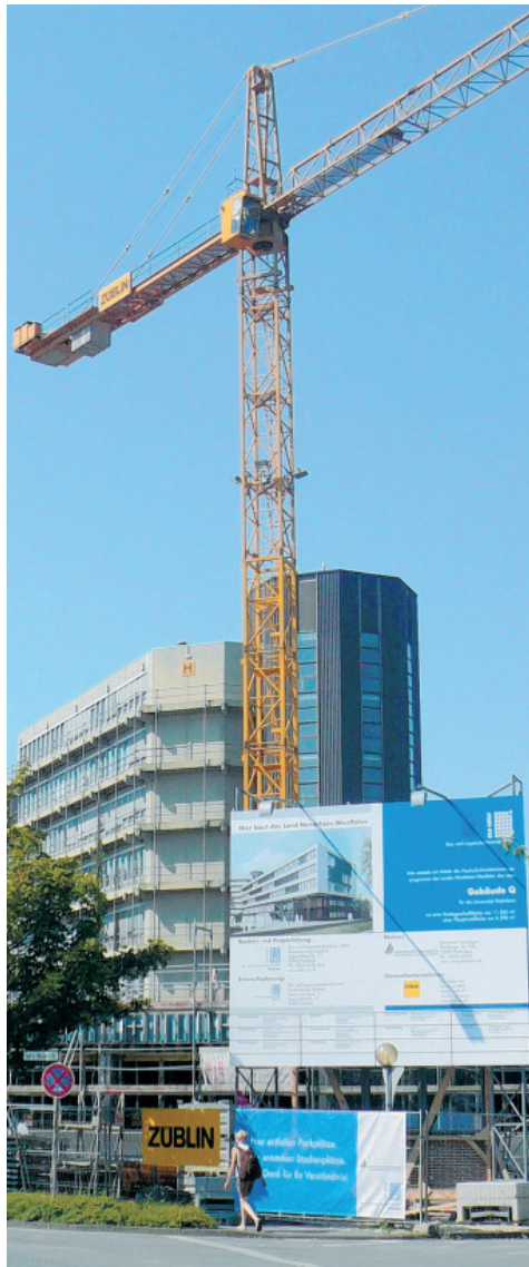
Wachstum: Seit Jahren gehören Baustellen zum Campus. Gerade wird am Eingang Gebäude „Q“ errichtet. Auf dem Plakat unten steht: „Hier entfallen Parkplätze. Dafür entstehen Studienplätze.“ FOTO: IGGES
