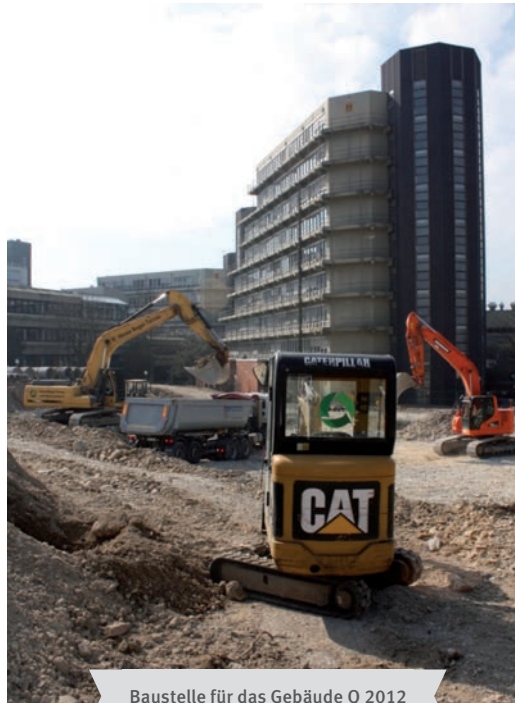
Baustelle für das Gebäude Q 2012
