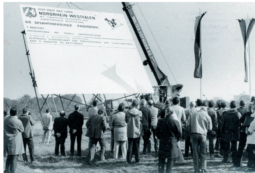
Okttober 1972: Zum Aufstellen des Baustellenschildes für das N-Gebäude wurde sogar geflaggt.
