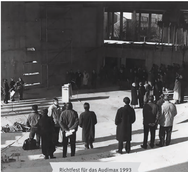
Richtfest für das Audimax 1993
