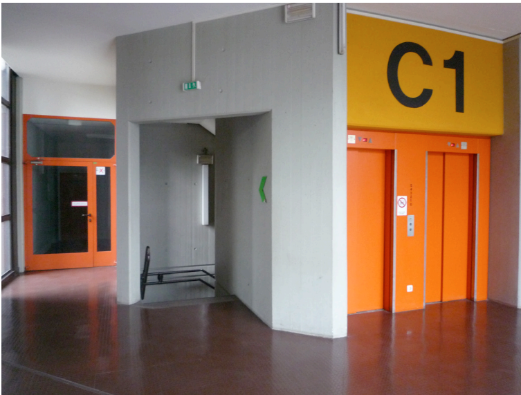
Abb.1.14 Die gleiche Situation, wie in Abb. 1.9, hier für Gebäudeteil C. Statt eines massiven Türblattes ist hier eine Glastür eingesetzt.
