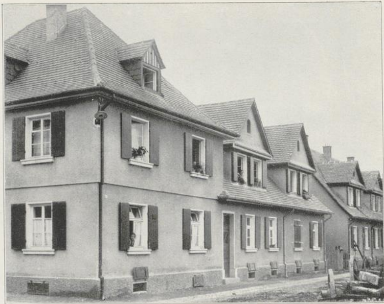
Abbildung 95 Siedlungshäuser der Gemeinde, (z. Zt. der Explosion im Rohbau).
