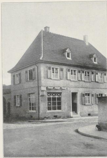
Abbildung 88 Ecke Friedrich- und Pilgerstraße. Handwerkerhaus.
