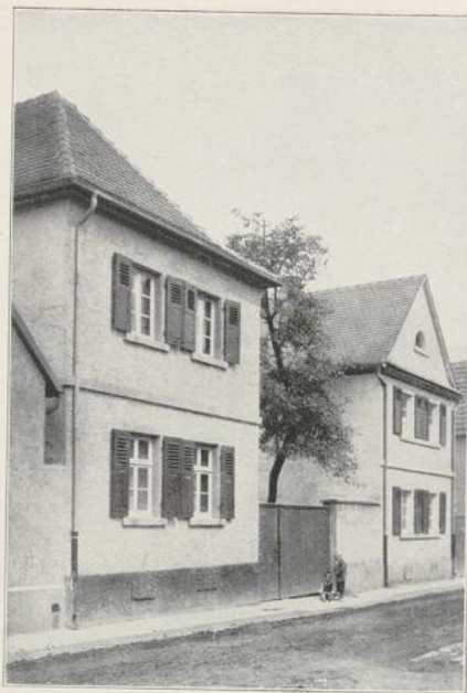
Abbildung 82 Westendstraße. Stockaufbauten auf weniger beschädigte Häuser.
