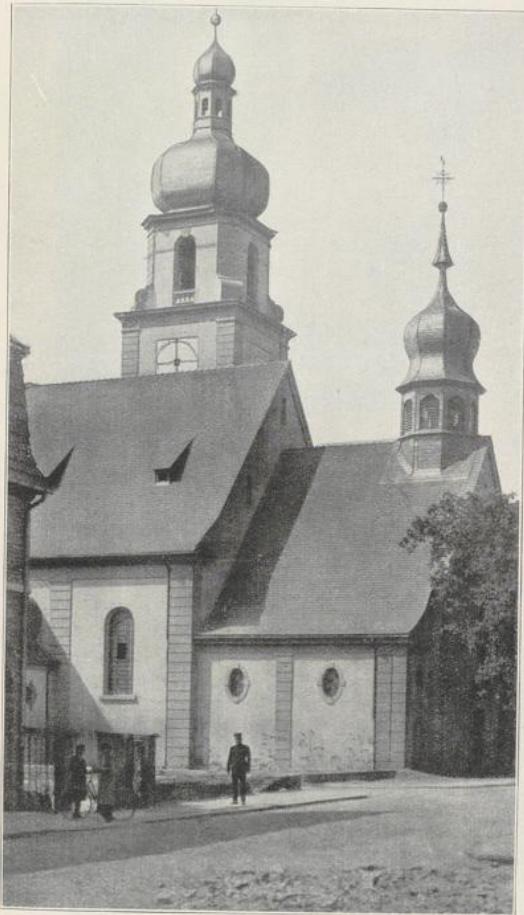
Abbildung 43 Kath. Kirche mit Vorbau und Dachreiter der alten Kirche.
