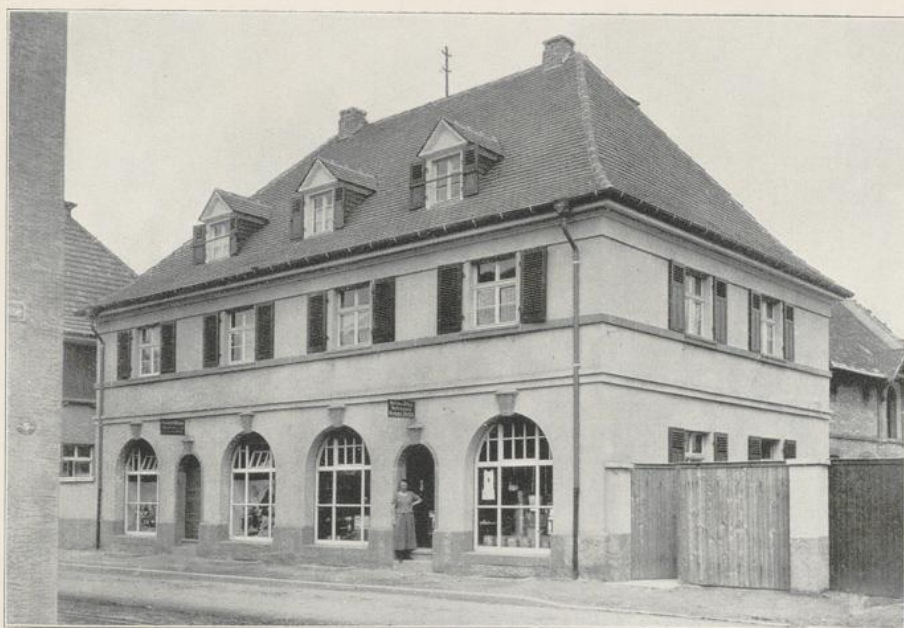
Abbildung 53 Geschäftshaus in der Edigheimer Straße.
