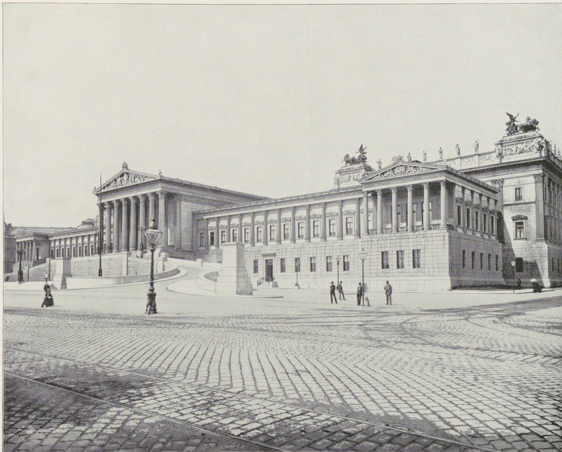
PARLAMENTS-GEBÄUDE IN WIEN. — Wer die Stadt Wien vor fünfundzwanzig Jahren gesehen hat, wird sie jetzt kaum wiedererkennen. Sie hat durch die Fertigstellung der Ringstrasse in jeder Beziehung viel gewonnen; diese Ringstrasse, eine Reihe von Boulevards, umgiebt das alte Wien wie ein Gürtel in einem Umkreis von fast 4 Kilometern. Doreinst umschlossen eine Festungsmauer und ein Graben die Stadt der Habsburger; allmählich aber sprengte sie, immer wachsend, diesen Gürtel; 1858 wurden die Wälle geschleift und geebnet, die Gräben ausgefüllt. Auf der hierdurch gewonnenen kreisförmigen Terrasse entstand die prächtige Ringstrasse, die mit ihren Promenaden das alte von dem neuen Wien trennt. Eine ganze Anzahl imposanter Gebäude, die sich mit den besten Leistungen der Architektur messen können, reihen sich hier wie die köstlichen Steine am Geschmeide aneinander. Wir bemerken hier unter vielen Anderen das erst vor einigen Jahren vollendete Parlamentsgebäude, dessen Kosten sich auf Millionen belaufen. Im classischen griechischen Styl erbaut, erinnert es an das Capitol in Washington. Von der Ringstrasse führt eine Rampe zum Gebäude, von welcher man in die prachtvolle, mit einer Doppelreihe von Marmorsäulen geschmückte Halle gelangt. Im rechten Flügel befinden sich die Räume der Abgeordneten, im linken das Herrenhaus; jeder derselben ist ein für sich unabhängiges Gebäude, reich mit Marmorstatuen und schönen Reliefs geschmückt; auch auf die grosse Centralgiebelgruppe und die bronzenen Quadrigen mit der Siegesgöttin sei hier aufmerksam gemacht.
