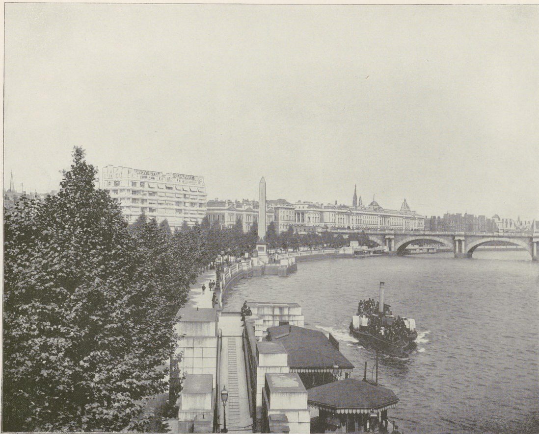
THEMSEQUAL UND OBELISK, LONDON. — Eine der grössten neueren Verschönerungen Londons ist das Themse-„Embankment“. Die Wand am Fluss ist aus Granit und deckt 2\frac{1}{4} Meter starkes, 12 Meter hohes Mauerwerk. Diese Mauer wurde zur Bildung eines 30 Meter breiten Fahrwegs errichtet, der mit Bäumen und Anlagen bepflanzt und mit verschiedenen Landungsstellen für Flussdampfer versehen ist. Auf dieser Strandpromenade steht jetzt eine der merkwürdigsten Reliquen des Alterthums, die der Welt erhalten blieb: der ägyptische Obelisk, allgemein bekannt als „die Nadel der Kleopatra“, die jedoch bereits 1500 Jahre früher, bevor diese „Sirene des Nils“ Cäsar und Antonius mit ihrer Schönheit betöhrte, aus dem rohen Block gehauen wurde. Die Ueberführung dieser „Nadel“ von Alexandrien nach England im Jahr 1877 erwies sich als ebenso schwierig wie kostspielig. Nach glücklicher Einschiffung in Alexandrien strandete das kleine, eigens für den Transport erbaute eiserne Schiff, und trieb einige Zeit verlassen in der Bucht von Biscaya umher. Ein vorüberfahrender Dampfer nahm es in Schlepptau nach dem Hafen von Ferrol, an der spanischen Küste. Von hier wurde es nach der Themse gebracht, und nun schmückt der Obelisk stolz ihr Ufer. Und doch muthet uns dieses Symbol der leuchtenden Sonnenstrahlen hier, in der Stadt des Nebels und des Rauches, an wie ein Verbannter aus einem Lande, wo nur selten eine Wolke den ewig klarblauen Himmel trübt. Wie so mancher grosse Landesverwiesene ruft auch der stolze Steincoloss an der Themse im staunenden Bewunderer die Erinnerung an die Macht und die Herrlichkeit des alten Aegyptens zurück, in Vergleich zu welchem sogar London eine Stadt der Neuzeit ist.
