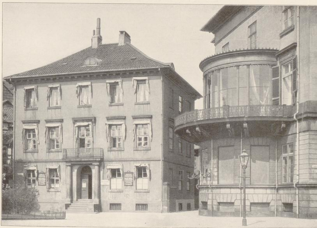
Hannover. Am Himmelreich und runder Anbau am alten Rathaus
