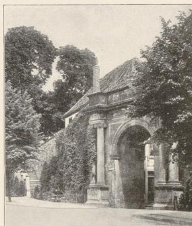
Osnabrück. Hegertor (Waterloodenkmal)
