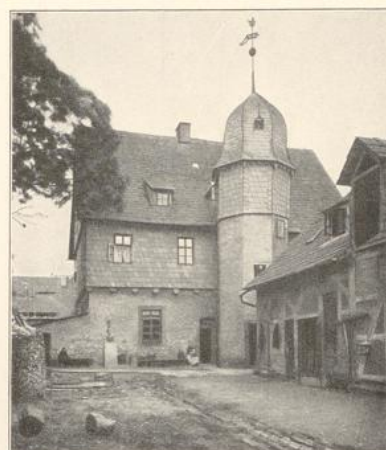
Allersheim, Kreis Holzminden. Gerichtsgebäude
