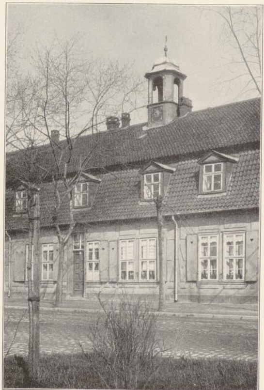
Herrenhausen bei Hannover. Nebengebäude vom Schloß
