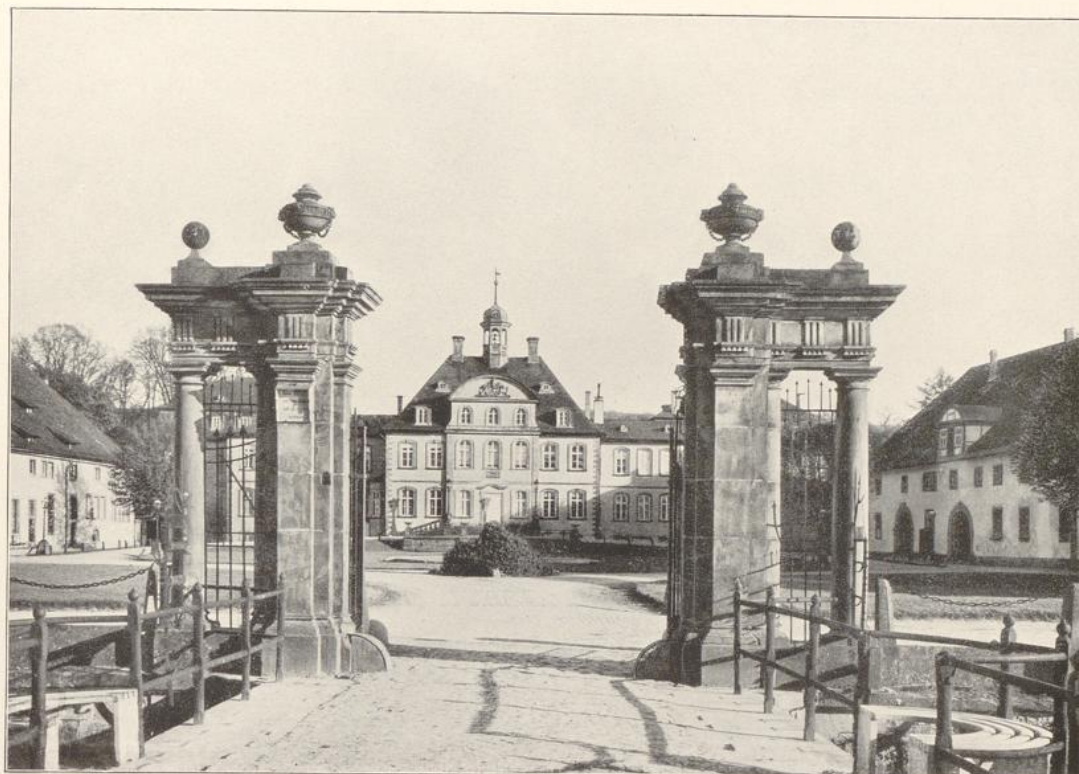
Einfahrtportal des Schlosses Söder, Kreis Marienburg
