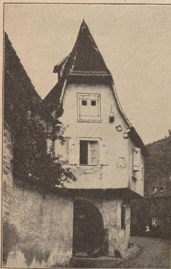
Rayfersberg. Haus in der Gasse bei der Brücke.
