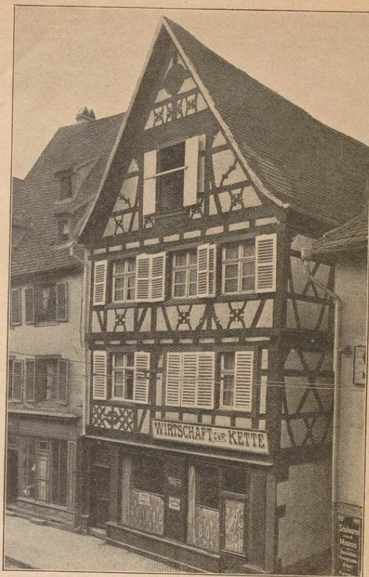
Colmar. Fachwerthaus. Baubanstraße 29. 17. Jahrh.
