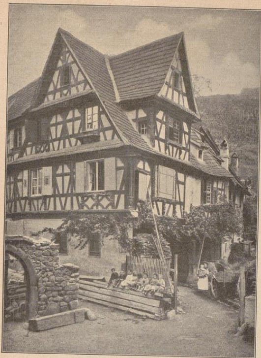
Andlau. Fachwerkhaus (abgebrochen). 17. Jahrh.
