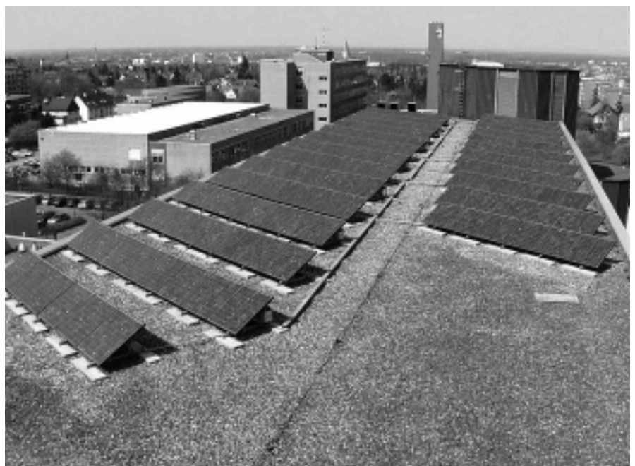
Solaranlage auf dem Dach der Universität.
